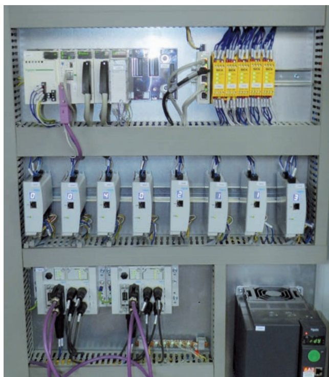
Hlavný rozvádzač linky s riadiacimi jednotkami pohonov Festo (v strede), komunikačnými modulmi CPX (vľavo dole) a hlavným riadiacim systémom (vľavo hore)
